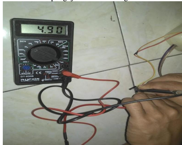
Gambar 4.1. Pengukuran Tegangan Catu Daya 5Volt Pada Output adaptor
