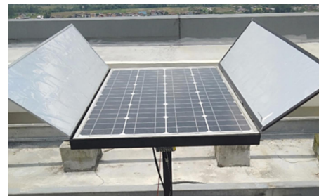
Gambar 5. Pengujian Panel Surya
