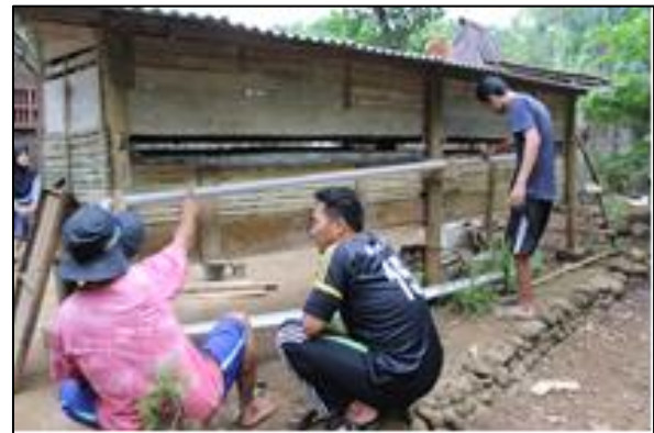
Gambar 3. Perbaikan Kandang Kelinci
