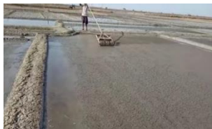
Gambar 4. Pemerataan dan pemadatan tanah(7)
