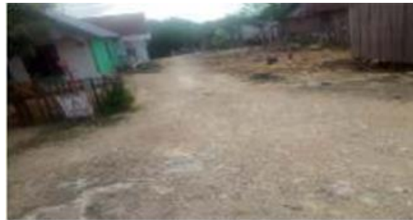
Gambar 7. Jalan Pogauha di Desa Parida Kecamatan Lasalepa Kabupaten Muna. (Sumber: Dokumentasi Pribadi)
