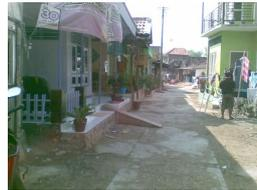
Gambar 11. Lantai rumah ditinggikan untuk mencegah genangan air masuk ke dalam rumah
