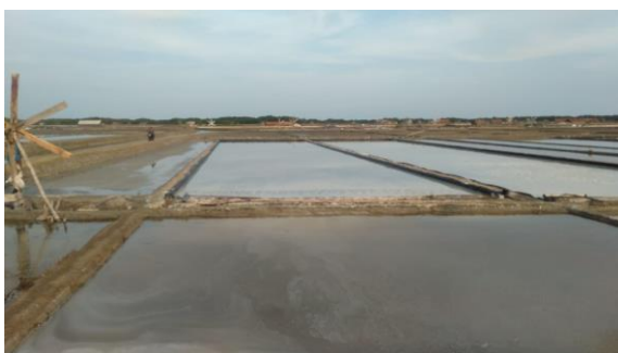
Gambar 2 : Gambar Lahan yang sudah di lapisii Teknologi Geomembran
