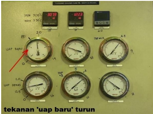
Gambar 1 Indikator yang Menunjukkan 'Uap Baru' Turun
